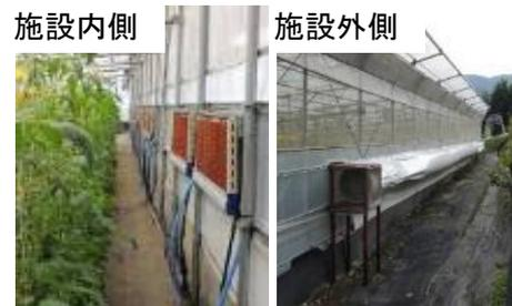
※ダクトをハウス中央に配置した場合は、簡易設置型パッドアンドファン本体を互い違いに設置します。
