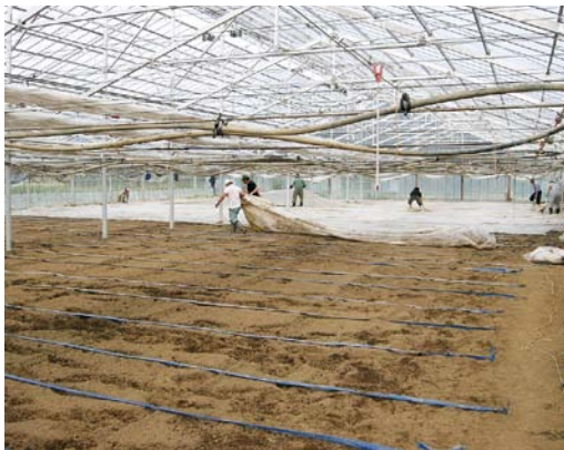
図45 ビニルで被覆する
