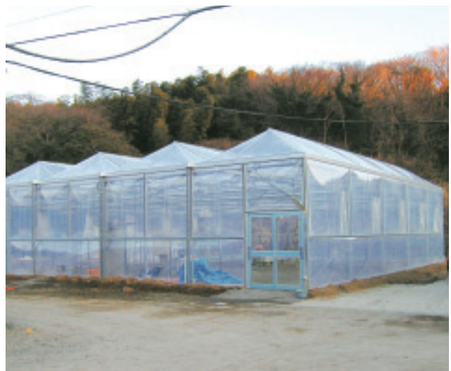
太陽エネルギー利用型の空気膜ハウス
