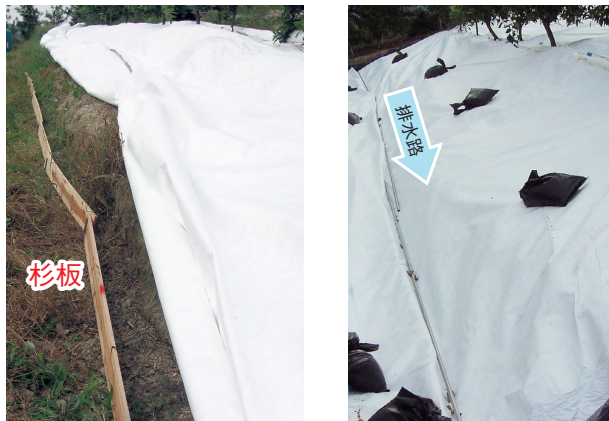
杉板（幅 105mm、厚さ 12mm、長さ 2m）を両側から杭で留める。
