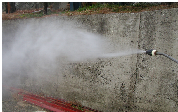
図1 高水圧剥皮機と水の吐出状況
