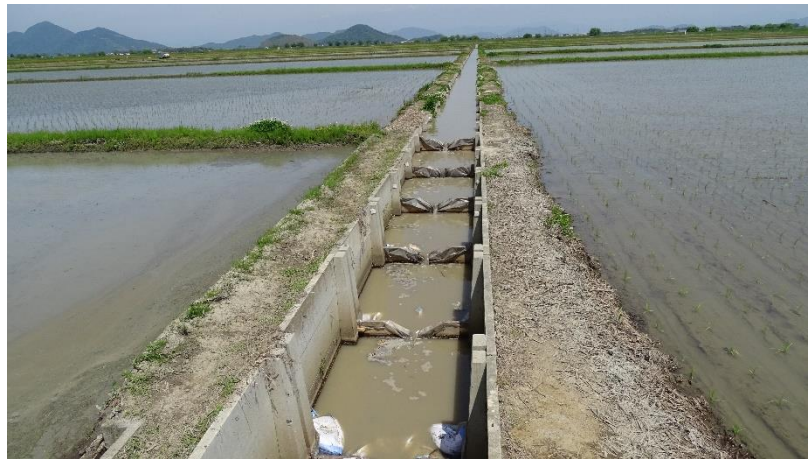
図 63. 排水路を堰上げした魚道
