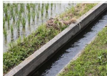
図 48. 流速の早い水路
