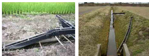
図 59. 水田魚道の例 （排水路のドジョウなどの魚が水田へ上れるようになる）
