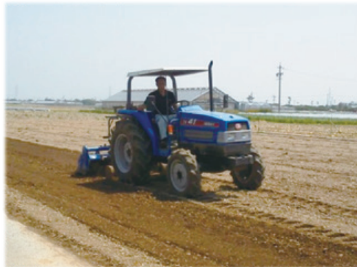
写真 8-4 ロータリーによる覆土作業
