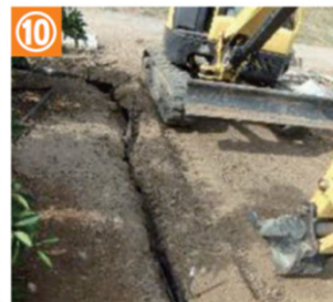
⑩ 掘削土を溝に戻す。
