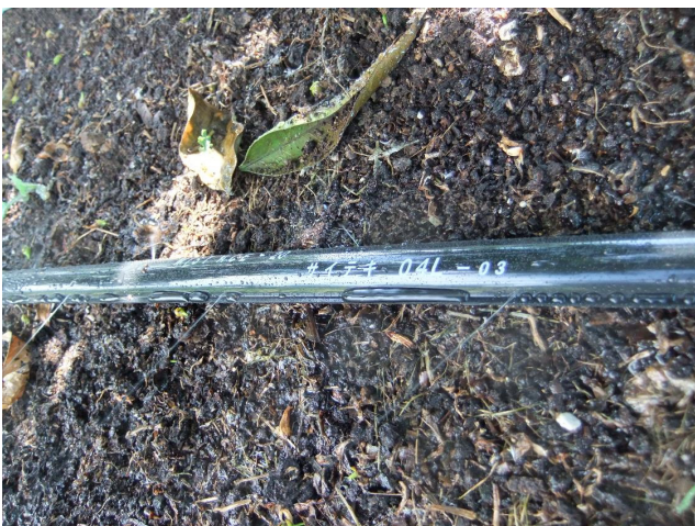
散水チューブ導入の様子
