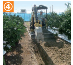
④ 白線に沿ってバックホーで掘削。
