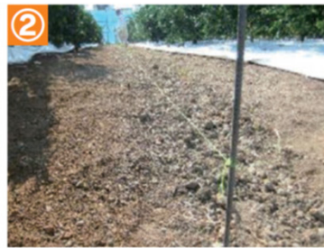
② 埋設位置に杭を打ち、水系を張る。
