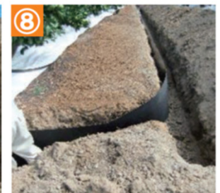
⑧ S.シートの埋設。 ※シートの継ぎ足しは50cm程度重ねる。
