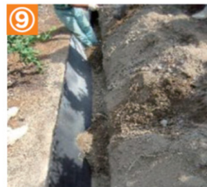
⑨ 畝側にS.シートを当て、地表面から5cm出して土を一部戻す。
