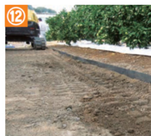
⑫ キャタピラーで転圧。 ※S.シートを踏まないように注意。
