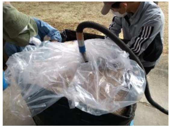
写真 2-4-10 掃除機を用いた内袋内空気の吸引
