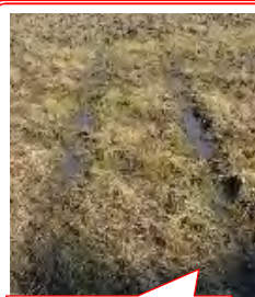
施工あとに滞水
