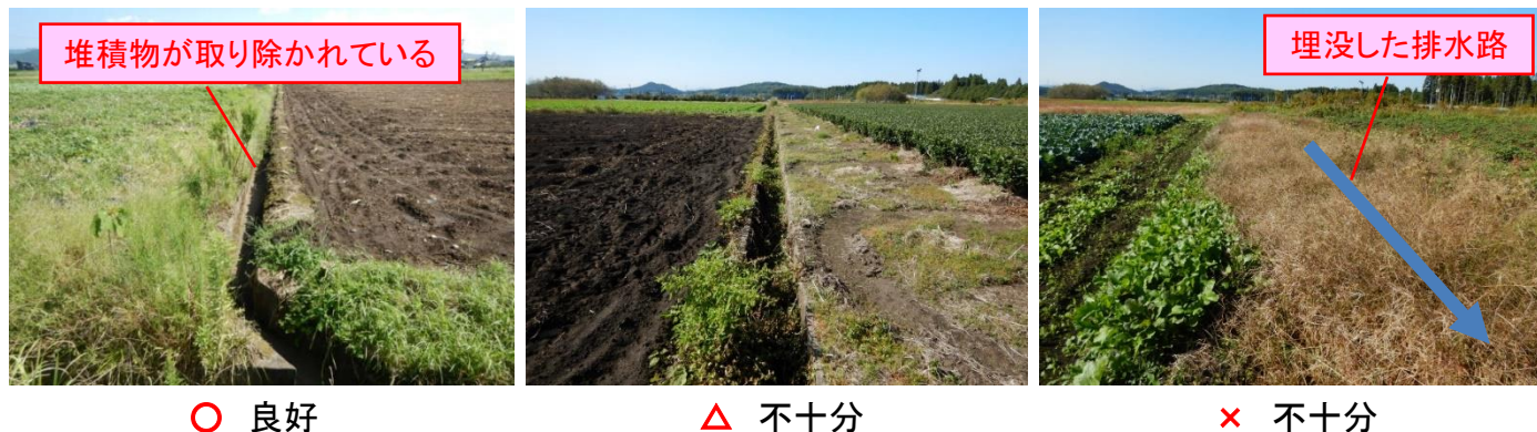
図40 支線排水路の管理状況
