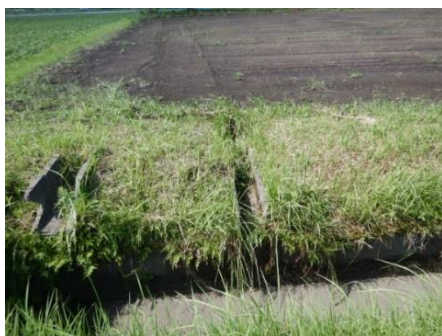
図41 排水路への接続と排水口の管理状況
