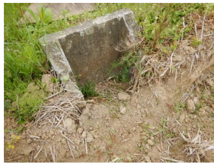
図41 排水路への接続と排水口の管理状況
