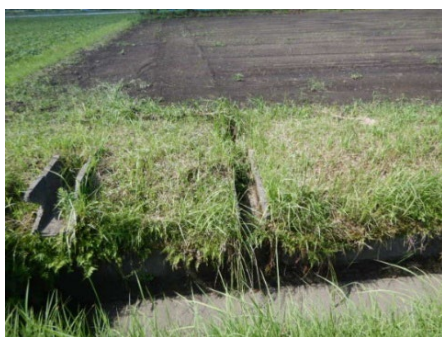
○ 排水路への接続が良好な排水口
