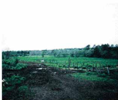
写真Ⅲ-16 排水溝がなく蒲鉾型断面をしていないため泥濘化した通路
