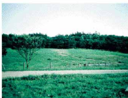
写真Ⅲ-17 両側に排水溝を備え、火山灰を敷いた良好な通路
