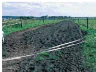
写真Ⅲ-40 メイン通路で山砂を投入(利用後)
