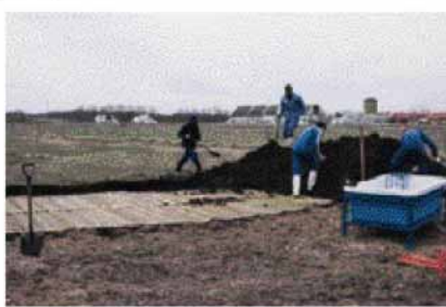
写真Ⅲ-38 水槽設置位置に木製スノコ設置
