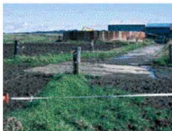
写真Ⅲ-41 牛舎出口から牧区ゲートまでのアスファルト舗装
