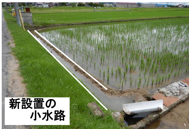
図3. 新たに小水路を設置した水田(東広島市、2015 年) 1 辺(17.5m に設置, 水田 15a の面積比 1.2% に相当)
