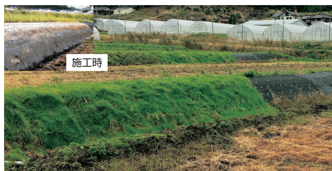
写真2 / わら芝を施工した法面
