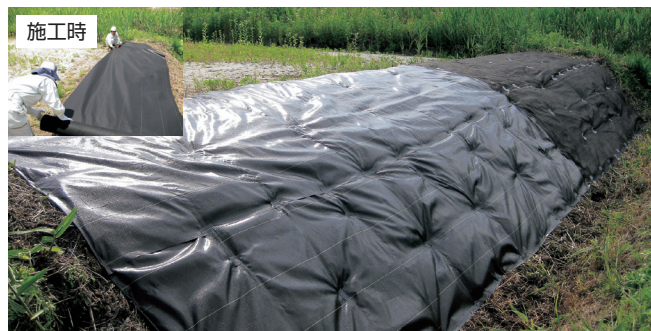
写真3 / 防草シートを施工した法面
