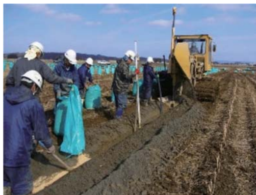
一般的な暗渠工事
