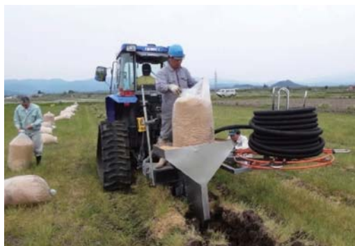
暗渠の施工状況 (85PSセミクローラ型トラクタ)
