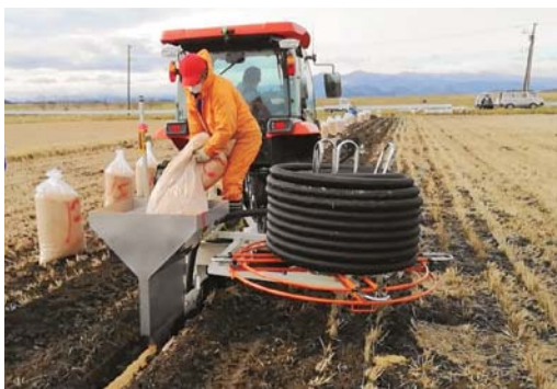
暗渠の施工状況(48PSトラクタ)
