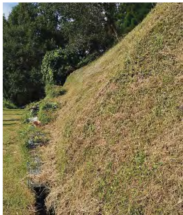
急傾斜畦畔(宮崎県50° 以上)
