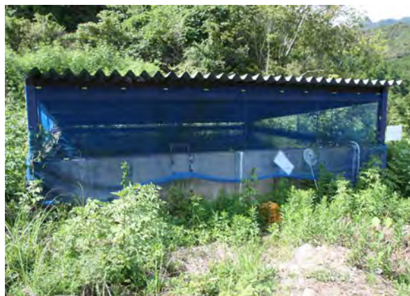
写真VI-1-11 N地区の水源（ファームポンド）
