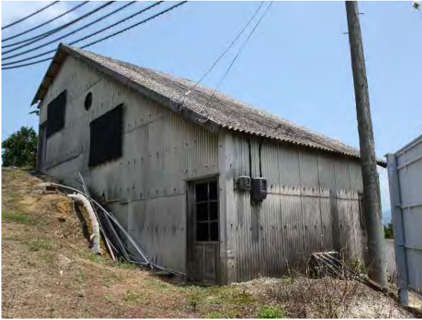
写真VI-3-1 共同利用施設を 設置した作業舎
