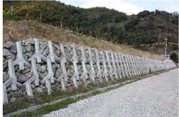
写真VI-4-4 園地の法面の1つ (ブランチブロック工法)
