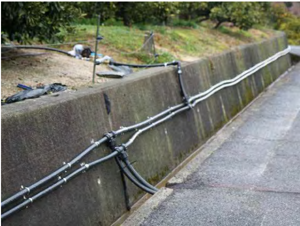
写真VI-3-3 複線式の配管
