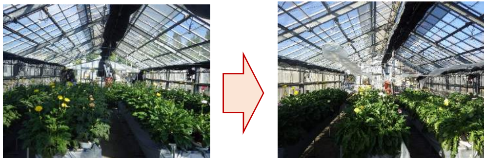
図21 ナノファイバー断熱資材により影の影響が減少
