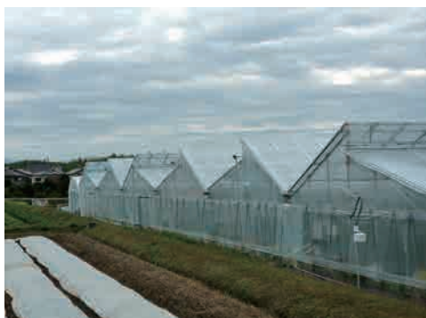
京都府京都市：約 20a（棟に段差式の天窗） 農業法人による業者施工
