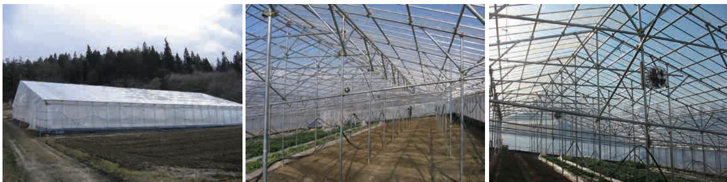
岩手県一関市：約 5.5a（屋根傾斜 15 度、圃場勾配 7 度） 県普及組織による施工
