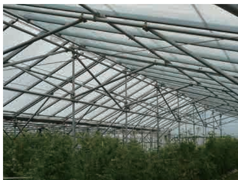
京都府京都市：約 20a（棟に段差式の天窗） 農業法人による業者施工
