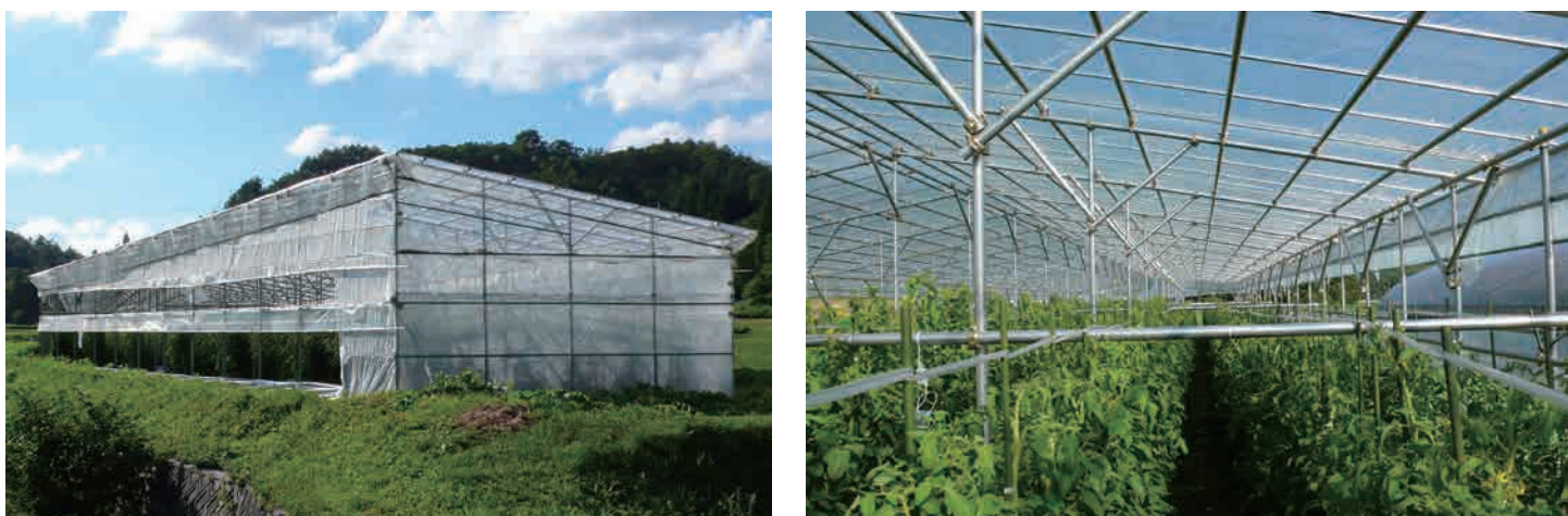
広島県北広島町：約 10a（12m×75～90m） 生産者の自主施工
