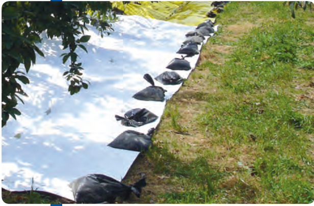
▲写真4 土のうを使った敷設
