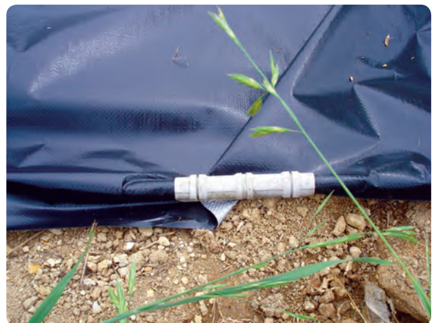
▲写真3 鉄パイプにパッカーで留める敷設
