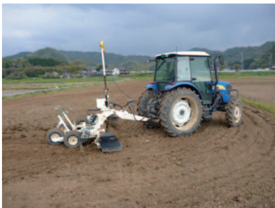
写真Ⅳ-4-1 均平・鎮圧・砕土
