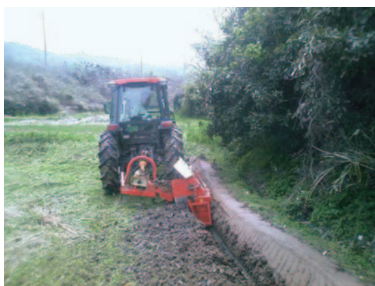
写真V-1 畦畔への明渠施工の様子
