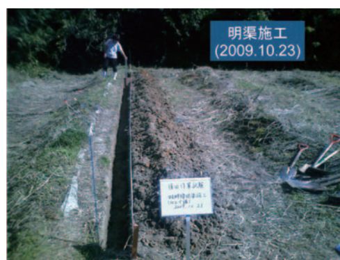
写真V-4 作業2：明渠施工
