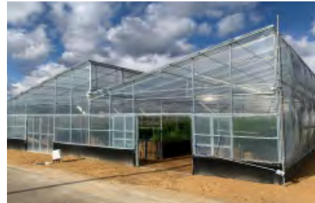
中山間施設野菜生産に適した建設足場 資材利用園芸ハウス
