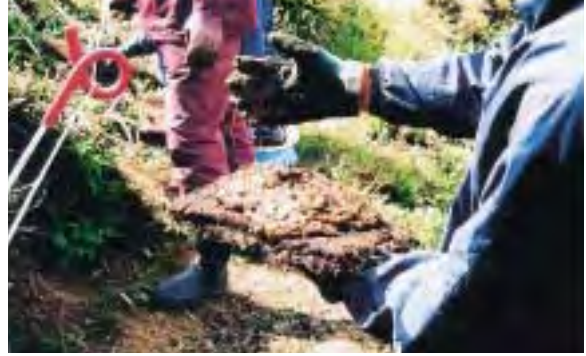
図2.67 修復作業（その1）
