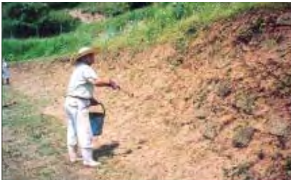
図2.68 修復作業（その2）
