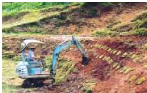
図2.53 人工牛道の敷設
