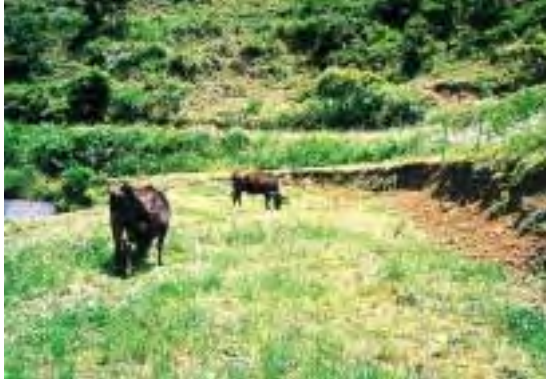
図2.43 放牧牛によって崩され裸地化した法面
