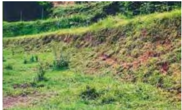
図2.69 修復が完了した法面
