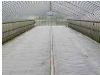
5 被覆中の様子(被覆資材は地面にしっかり貼り付くように)
