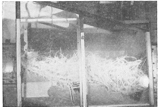
第 II-12図 ストローラック上のわらの動き
