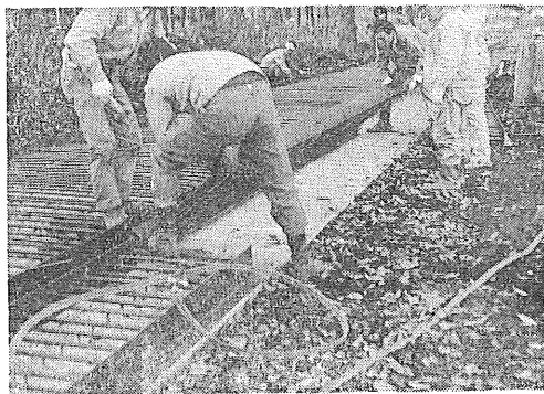
図28 第2次人工悪路建設風景 (I) (梯子の構造及び鋼管下側のアンカーに注意)
