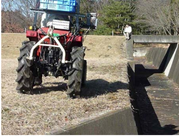
図7 コンクリート製水路脇の未舗装路
