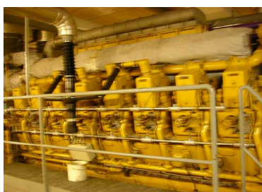
図32 V16気筒エンジン 天然ガスを燃焼し、ポンプを駆動する ヴェローナ博でこれのバイオガス仕様を見た
