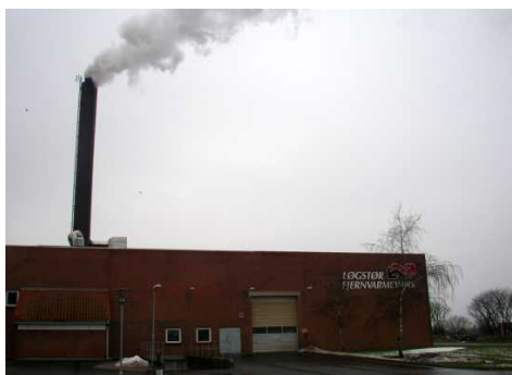
図28 ログスター温水供給センター 人口 5000 人の町の暖房をこのセンターで一手に賄う。ここから全戸へパイプラインが通じている。
