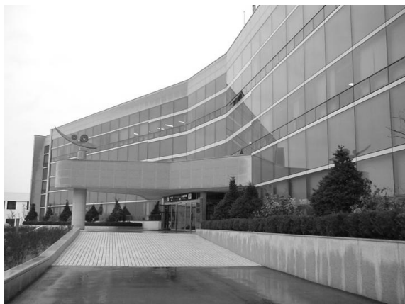
写真 11 農業工学研究所本館
