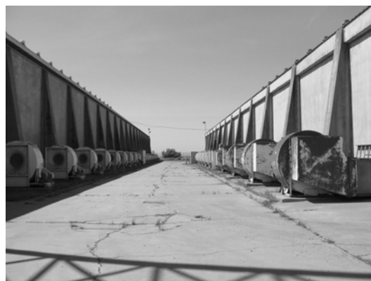
図4 米の乾燥貯蔵施設
