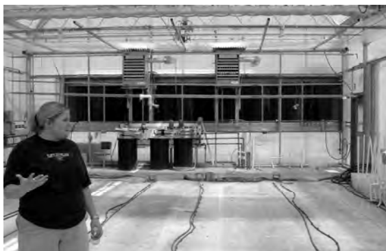
図 9 パット&amp;ファン方式の冷房
