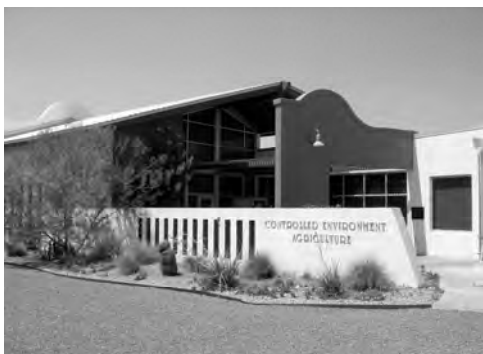
図 7 環境コントロールセンター
