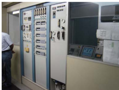
図 3 排ガス分析装置
