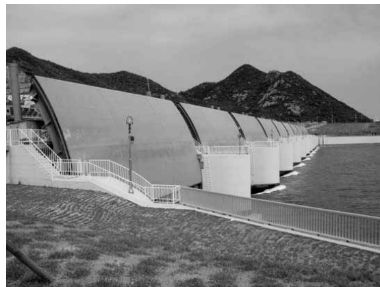
図 13 セマングム防潮堤の水門
