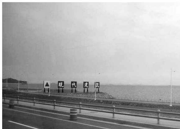
図 12 セマングムの堤内
