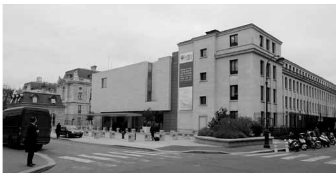
図 1 会議場（OECD コンファレンスセンター）全景
