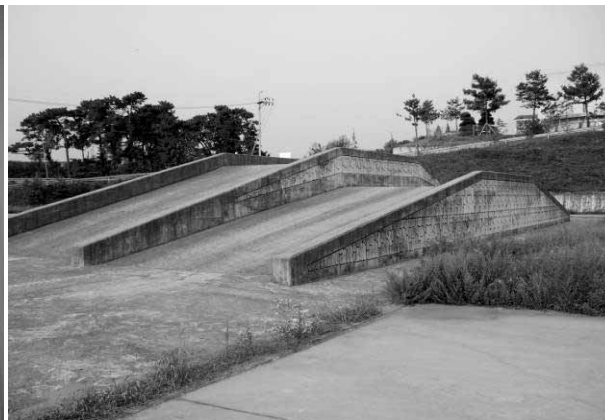
図3 傾斜路面（駐車ブレーキ確認）
