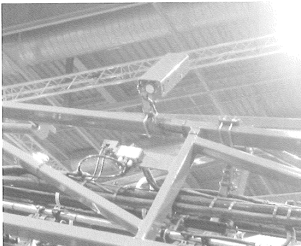
図 11 ブームに取付けられた超音波センサ
