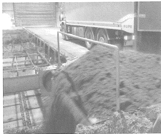
図 22 バイオマス燃料搬入の様子
