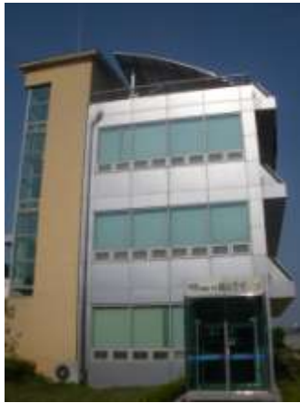
図 1 植物工場研究棟外観
