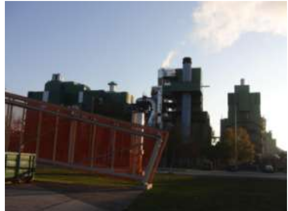
図 24 プラスチックゴミ焼却-発電プラント
