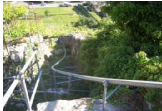
図 14 レールの敷設状況
