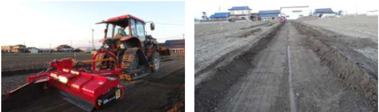
図 12 法面表土削り取り機 (一部改良) による水田表層土の削り取り作業と往復処理後の様子
