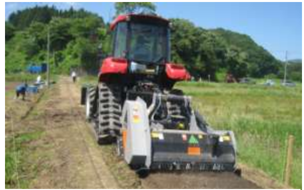
図 8 農道表層の除染作業
