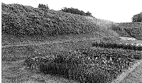
Photo 19 復旧工事後8年目のNo.2法面
