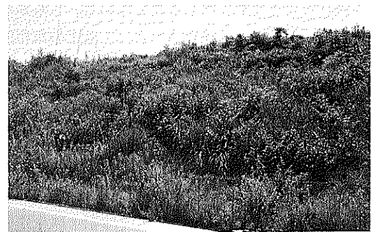
Photo 7 復旧工事5年後の法面(Fig.7のA)
