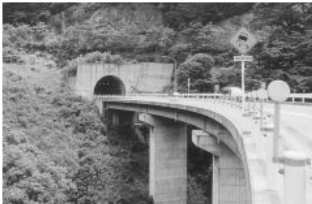
Fig.1 道路施設の例（橋梁およびトンネル） Concrete structure of road ( bridge and tunnel)
