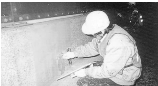
【道路分野のコンクリート構造物】
