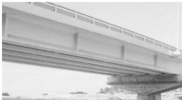
【道路分野のコンクリート構造物】
