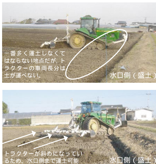
Fig.13 斜め走行による水口側の運土状況
