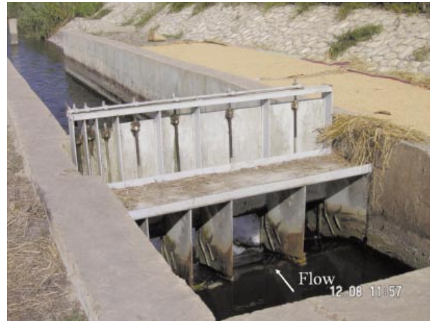
Fig. 16 バフルが切断されたダブルバフルディストリビュータ (West Sydy Salm地区)
