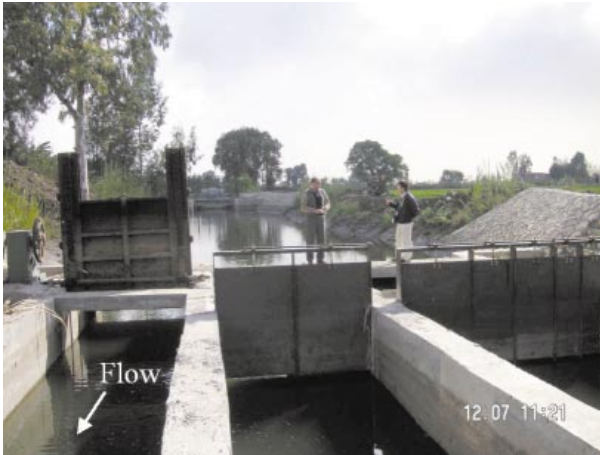
Fig. 14 ディストリビュータに併設された全開放状態の緊急放流ゲート (Dsook地区)
