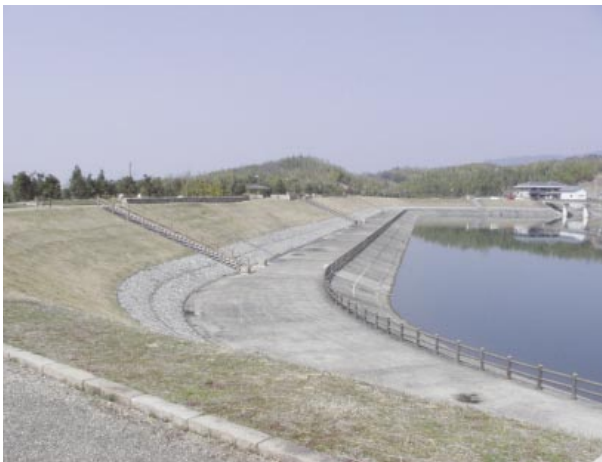
Fig.30 白川ダムの改修後の堤体上下流側の状況を示す Upstream view of Shirakawa dam
