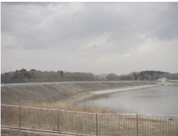
Fig.7 山倉ダムの改修事例 Upstream view of Yamakura dam
