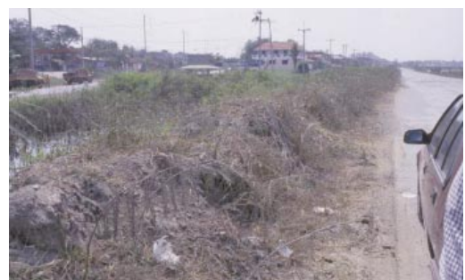
Fig.38 チャオブラヤ川からの洪水時背水からパクハイ地区内を守るための堤防 (地区外から撮影) (Fig.21)
