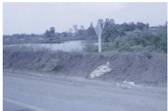
Fig.32-3 バンバン地区北東部揚水機場の小屋外の堤防の応急嵩上げ工事の跡
