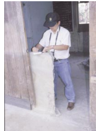
Fig.32-2 北東部揚水機場の応急コンクリート壁 (メモをしている台部分)
