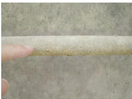
Fig.19 水深6～8m付近の梯子階段に付着したスケール
