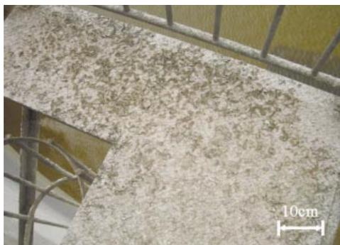
Fig.38 水深1～2m付近の階段の踊り場付近の藻の発生状況
