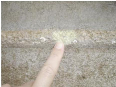
Fig.13 水面付近の梯子階段に付着したスケール
