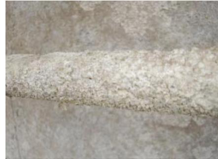
Fig.15 水深1~2m付近の梯子階段に付着したスケール
