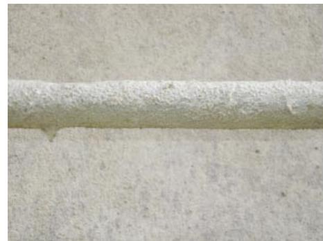
Fig.17 水深3~5m付近の梯子階段に付着したスケール
