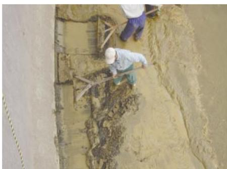
Fig.21 ファームポンドの底における堆積物の堆積状況
