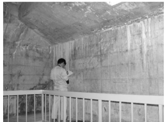
Fig.3 ポンプ室内のコンクリート (ポンプ室内コンクリート) Inside the pump station
