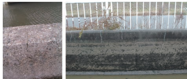
Fig.4 水路天端からのひび割れ発生状況例 Examples of crack
