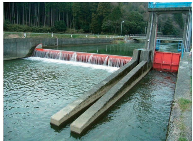
Fig.1 頭首工のゲートに設置されたスポイラ Spoilers on the gate of headworks
