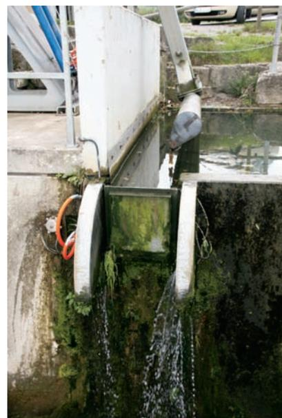
Fig.10 ゲートタイプの除塵機
