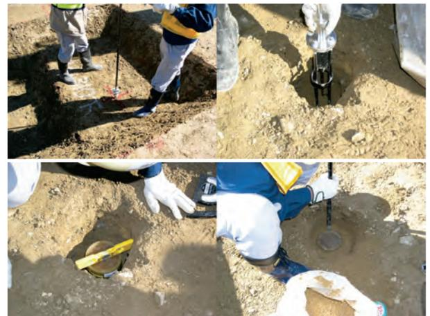
Fig.6 ワイヤレス間隙水圧計の設置状況
