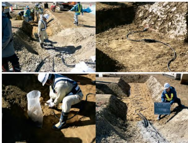
Fig.5 ケーブル式間隙水圧計の設置状況
