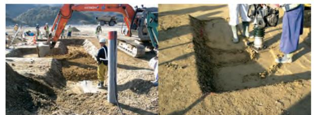
Fig.7 ケーブルトレンチの埋め戻し状況
