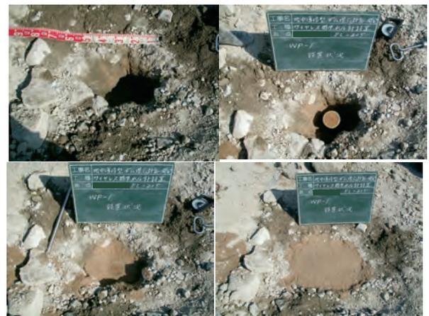
Fig.16 半透水性ゾーンにおけるワイヤレス間隙水圧計の設置状況
