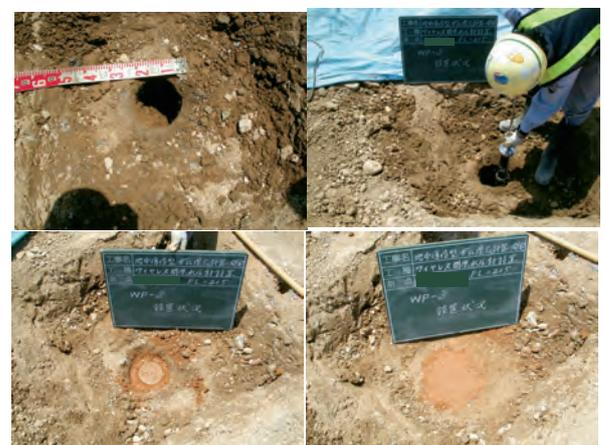
Fig.17 コアにおけるワイヤレス間隙水圧計の設置状況
