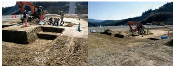
Fig.4 ケーブルトレンチおよび間隙水圧計設置位置の概観
