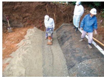
(h) 砕石を撒き出し、転圧する
