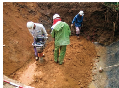
(f) ランダム材を撒き出し、転圧する
