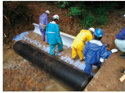
(b) 壁面型枠を設置する
